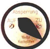
**Zum Heizen muß immer der Rauchabzug (Klappe oder Schieber) geöffnet werden!**
